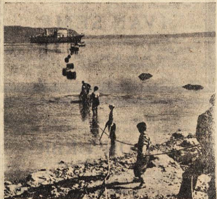
Na sliki vidite začetek del pri polaganju prekooceanskega telefonskega kabla. Kabel so začeli polagati pri mestu Clarenville v Newfoundlandiji. Kabel bo začel delovati leta 1956 in bo povezoval Anglijo in ZDA. Podrobneje smo o tem že poročali v našem listu
