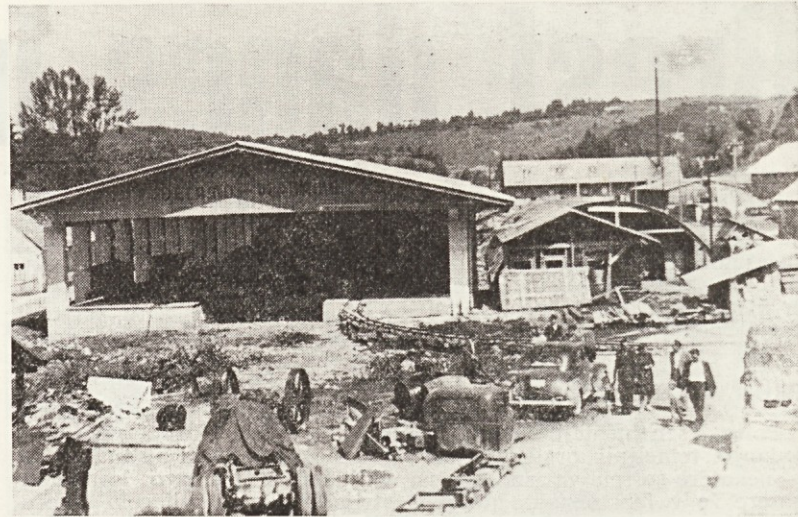
Gradnja prve večje proizvodne hale v Cerknici
