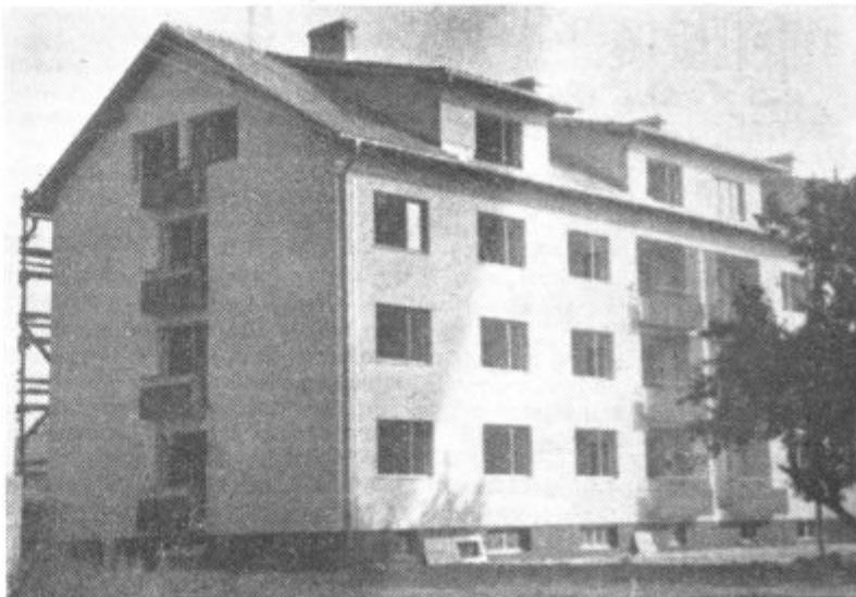
Hišnemu svetu št. 4 v Lenartu se bo kmalu priključil novozgrajeni 21-stanovanjski blok, na katerem bodo dela v kratkem končana. (Foto T. Stefanec)
