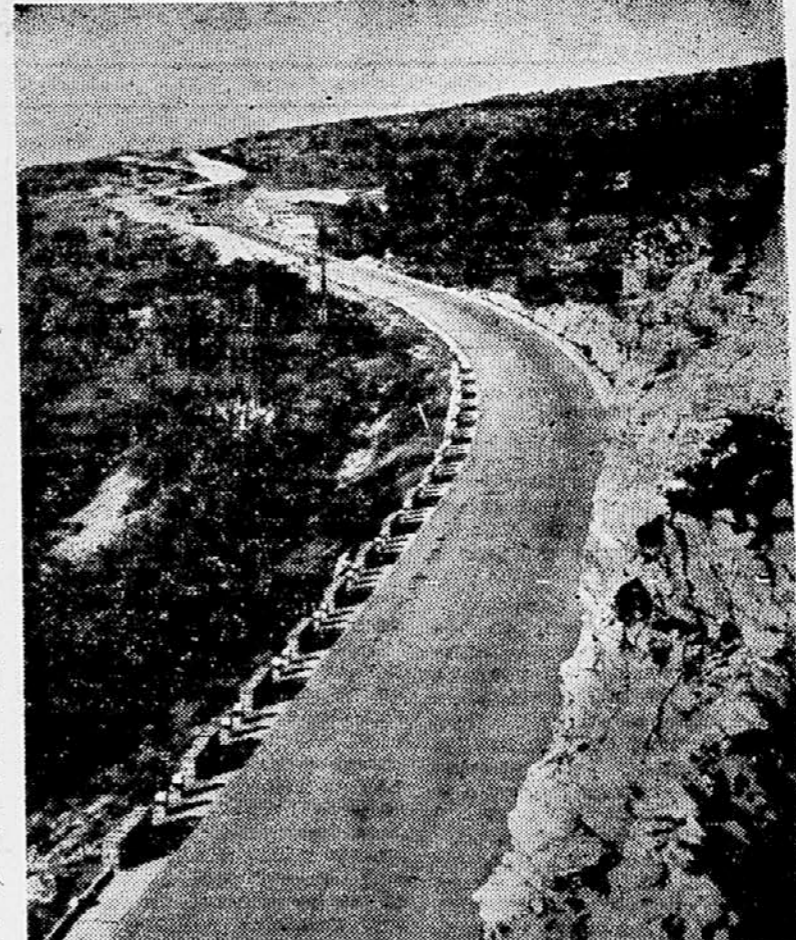
Detalji modernega voziča koprške ceste pred Kastelcem. — V ozadju nadaljevanje v asfaltbetonu. (Foto Strnad Peter)
