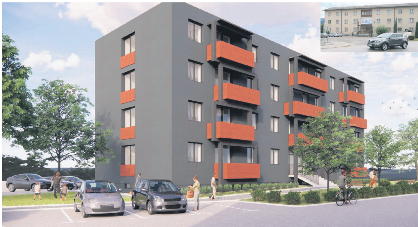
Zgradba »stare občine« (zgoraj desno) naj bi še do konca letošnjega leta dobila novo podobo. V štirih etažah bo 19 dvo- in trisobnih stanovanj. Foto: Remont, arhiv NT
