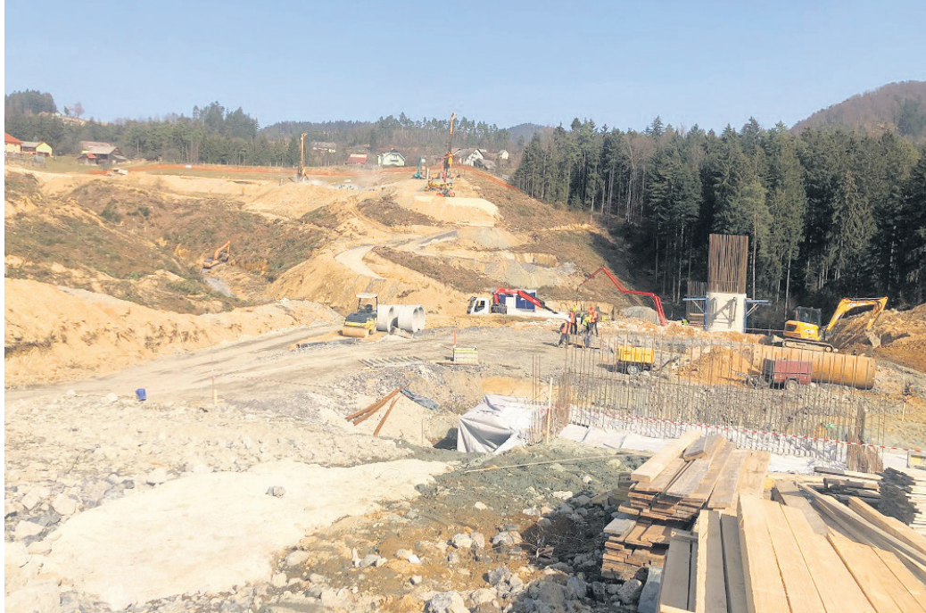
Gradbišče tretje razvojne osi v Gaberkah
