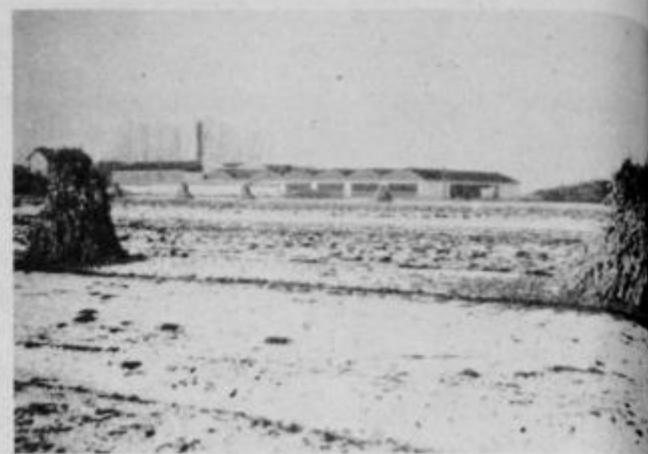
Pozimi je bil precejšen del zgradbe že pod streho.
