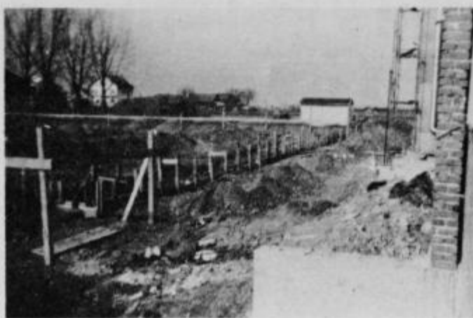
Tako se je začelo, najprej je bilo treba zabetonirati temelje
