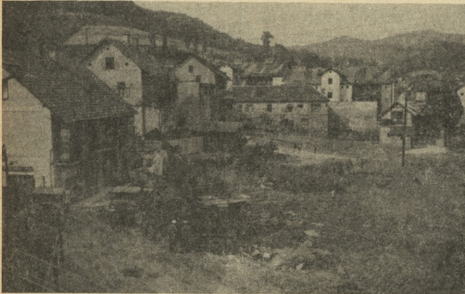
Gradbišče Delavskega doma Trbovlje v začetku maja 1953.
