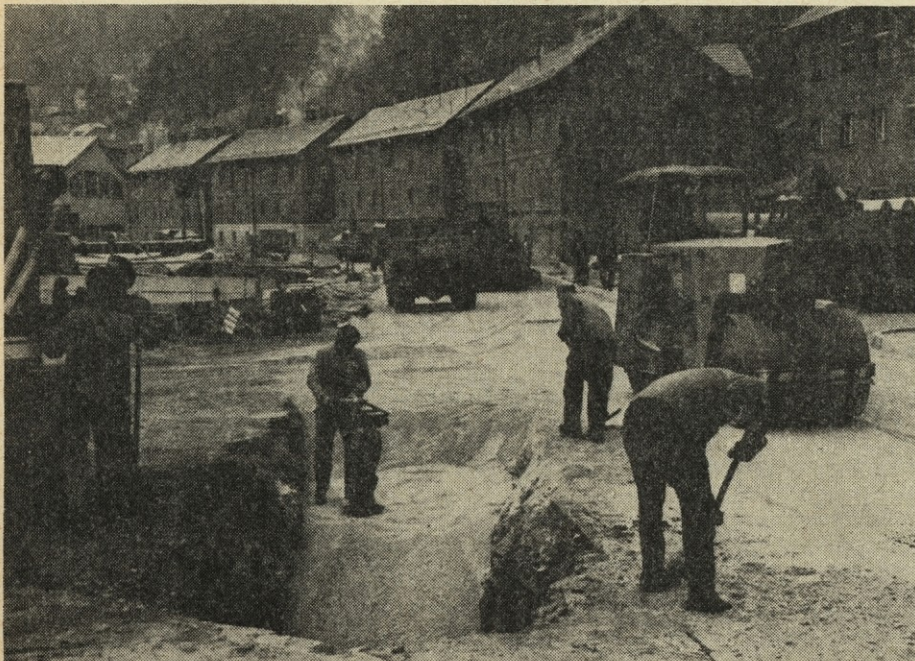
V drugi polovici leta 1986 so pričeli z modernizacijo glavne ceste v Trbovljah na odseku od "Zavraška" do rudniškega gasilskega doma. Dela bi morala biti končana do 20. novembra 1986, vendar so se močno zavlekla. (Posnetek od 19. novembra 1986).
