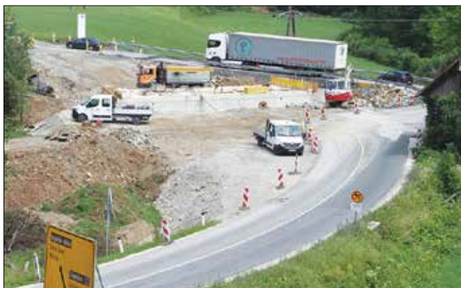
Delavci trenutno zasipavajo okolico betonske konstrukcije, ki bo varovala potok, in izdelujejo nasipe.
