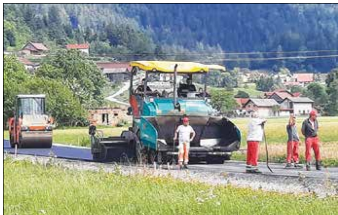
Delavci koncesionarja VOC Celje so v ponedeljek zaključili asfaltiranje dela ceste od Rečice proti Žekovcu.
