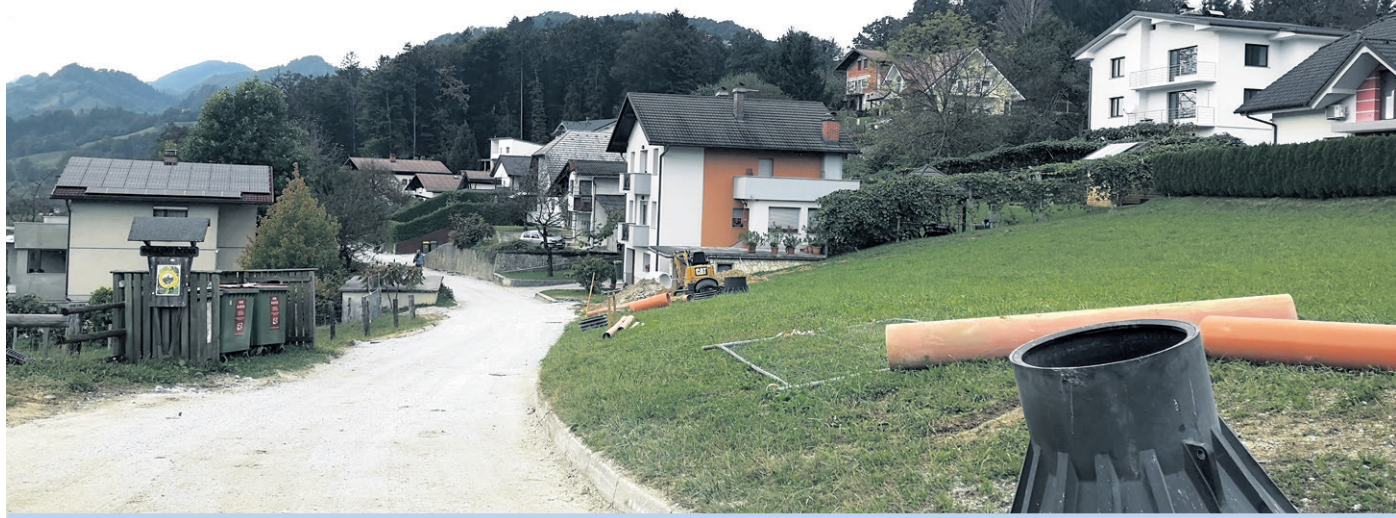
LAŠKO – Gradnja kanalizacije v Marija Gradcu in Lahomnem ter starem mestnem jedru
