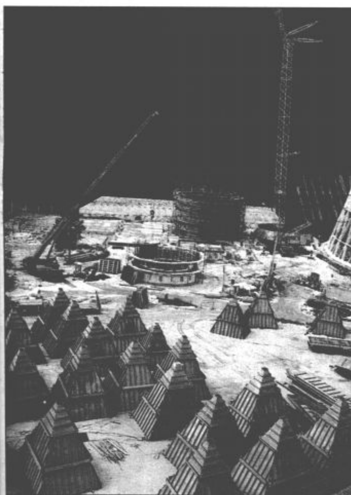
Pogled na gradbišče razžveplalne naprave bloka pet. Stožci v ospredju so zbiralniki pepela in bodo vgrajeni v elektrofilter. Majhna objekta v ozadju sta v resnici zelo velika, v njune temelje je bilo vgrajenih šest tisoč ton betona, predstavljata pa osrednja objekta razžveplalne naprave.
