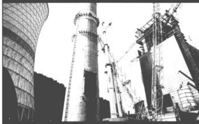
Šestotonski žerjav so morali pripeljati z Norveške. V odprtine na dimniku in bloku bodo vgradili naprave za čiščenje dimnih plinov.
