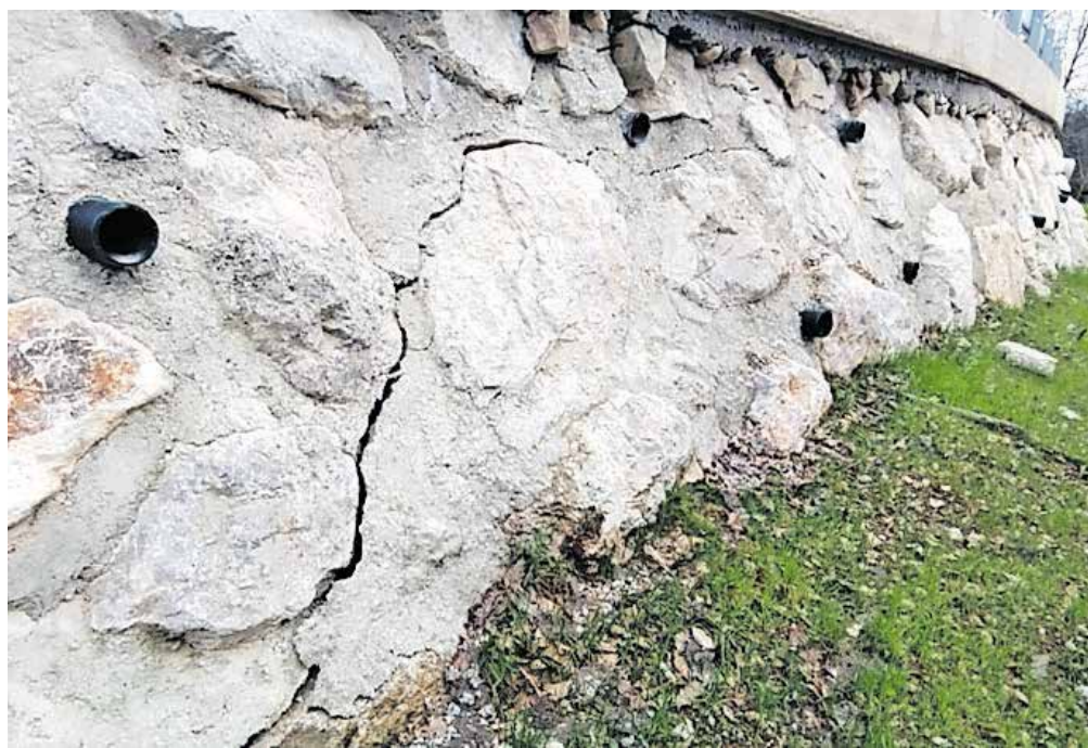
Razpoke na škarpah, ki so vzbudile dodatno zaskrbljenost domačinov, so sanirali.
