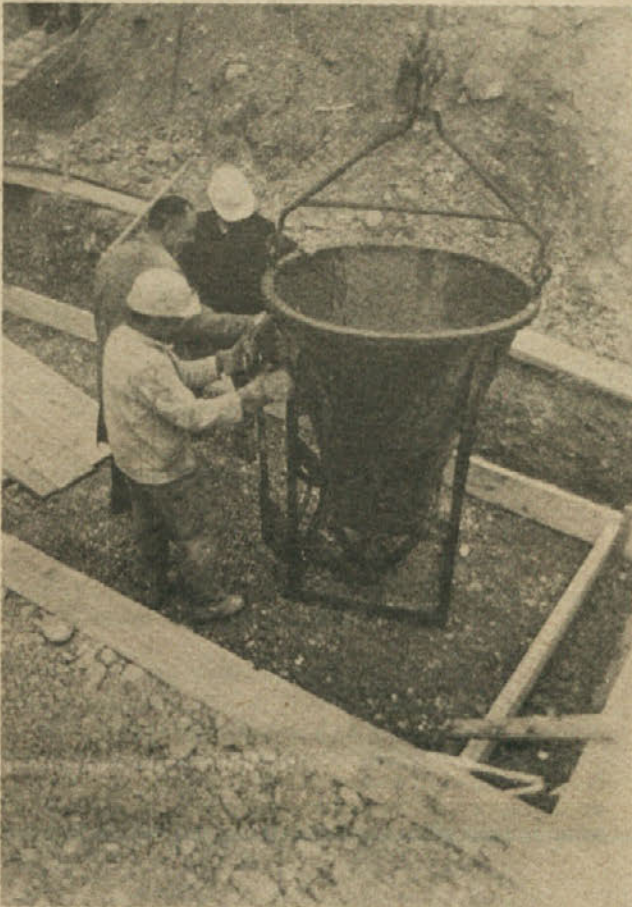
Predsednik občinske skupščine polaga prve temelje nove stavbe VEKŠ-a
