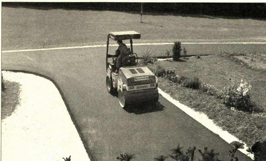
Končno! Asfalt tudi na Hlevišah.
