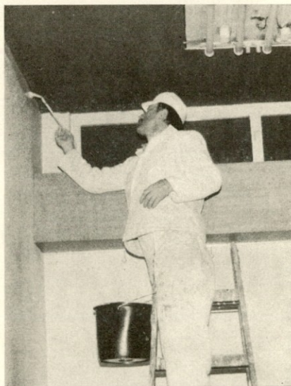
V novembru je zunanji izvajalec prepleskal hodnike v upravni stavbi
