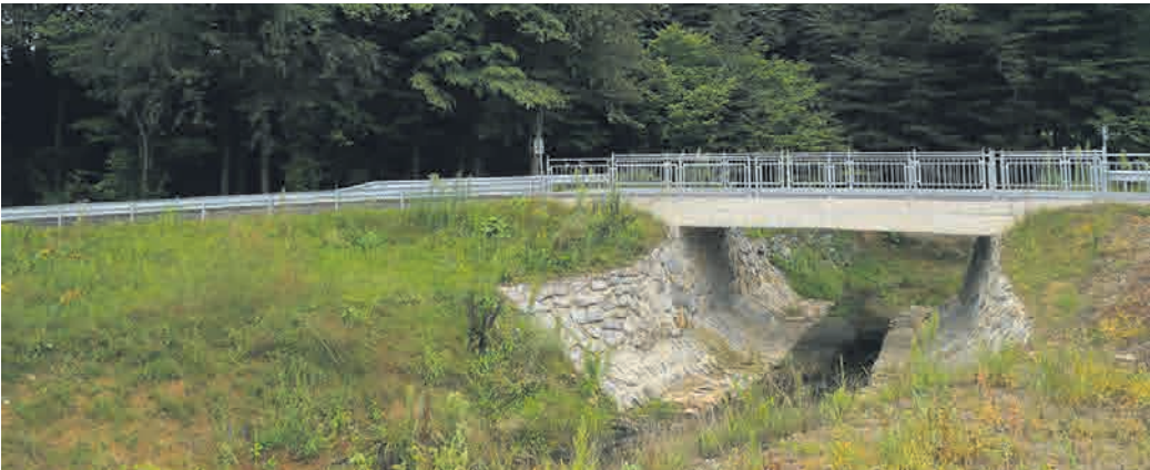
Lani je občina uspešno sanirala most v Dolanah v vrednosti 274.000 evrov. Naložbo je izvedlo KP Ormož. Drugo leto nameravajo obnoviti še most na Pohorju, ki je bil poškodovan v poplavih leta 2023. Projektantska vrednost naložbe znaša okoli 268.000 evrov.
