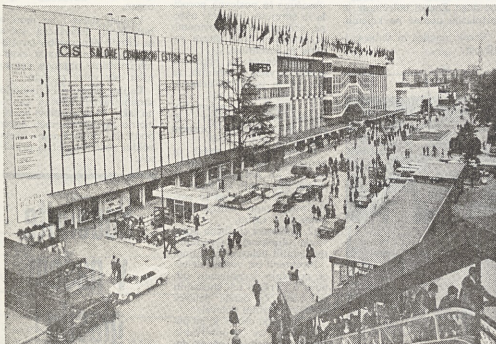
Pogled na vhodno zgradbo, kjer je bil velesejem
