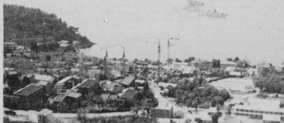
Panoramski pogled na Petrovac s ceste nad njim. V ospredju ponazarjajo gradbišče novega hotela Palas zaenkrat le še štirje veliki žerjavi.
