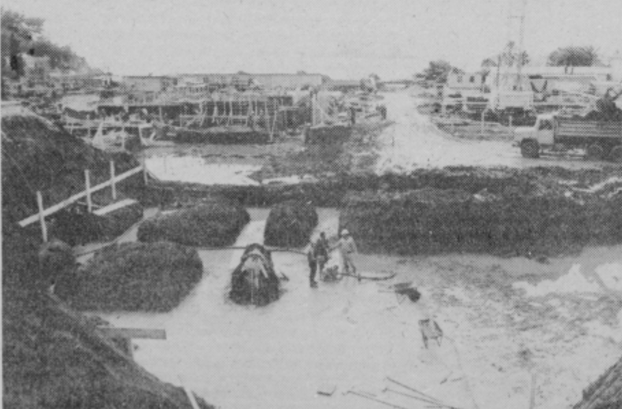
Posnetek dovolj zgovorno priča, s kakšnimi težavami zaradi velikih količin podtalnice so se morali in se še spoprijemajo gradbinci. Posnetek je sedaj star mesec dni.
