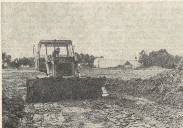
Prvi kubični metri izkopane zemlje nove gumarne
