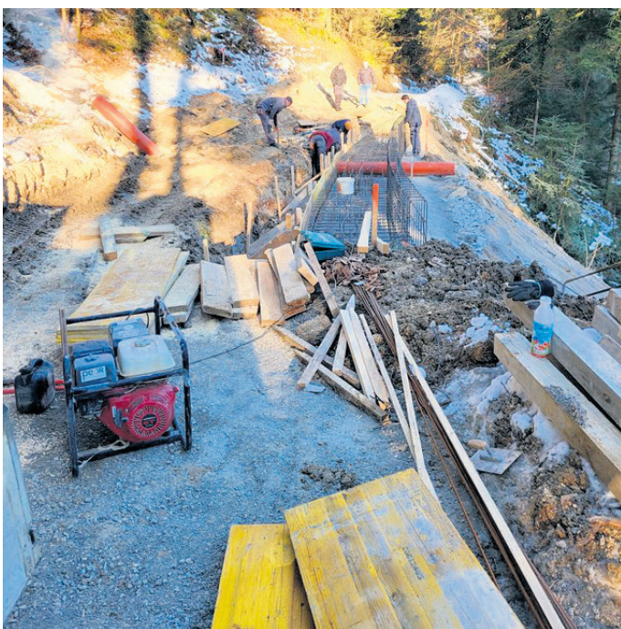
Zahtevno urejanje več kot sto metrov dolgega plazov na cesti v Malih Dolah z gradnjo podporne konstrukcije, s postavitvijo pilotne stene, z ureditvijo odvodnjavanja površinskih in podtalnih voda in obnovo ceste bo stalo skoraj 338 tisoč evrov.
