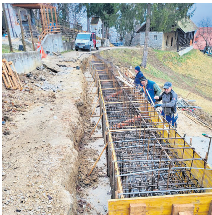
V Straži pri Novi Cerkvi je plaz ogrozil prevoznost javne poti. Podporna konstrukcija s piloti (v dolžini 25 m) bo omogočila stabilizacijo in prevoznost ceste.
