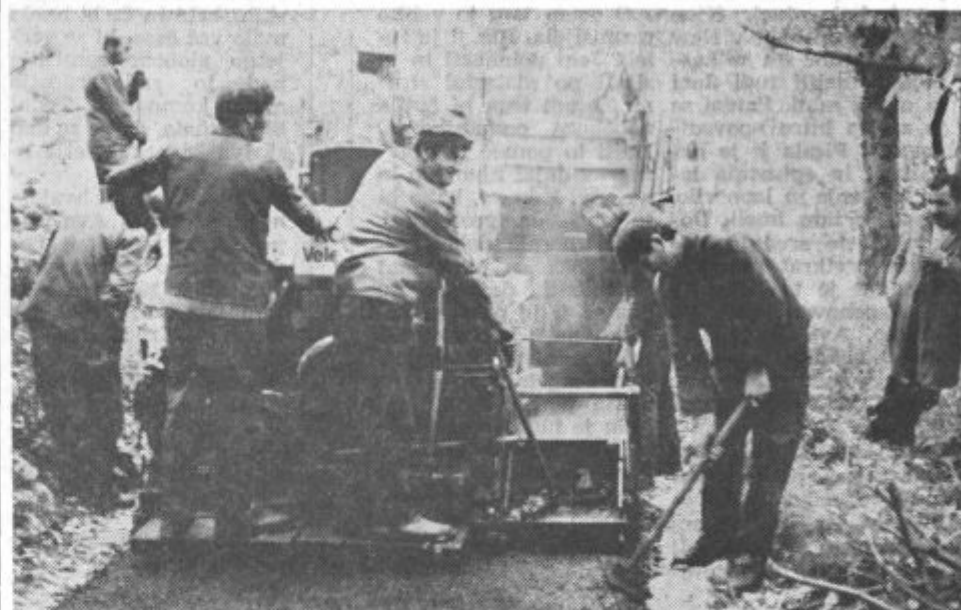
Delavci komunalno obrtnega centra Velenje polagajo asfaltno prevleko na vaške ceste v krajevni skupnosti Smartno ob Paki
