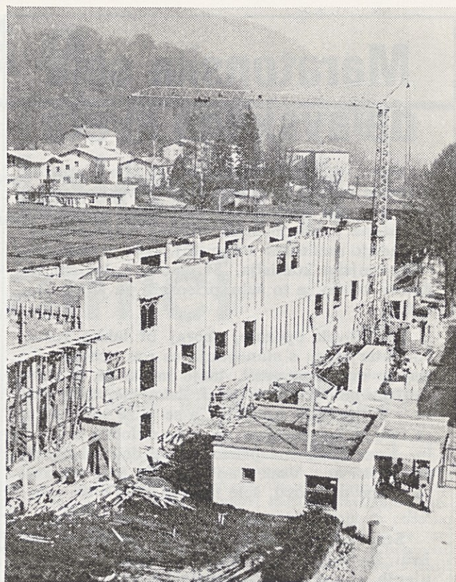
Novo halo še vedno gradimo
