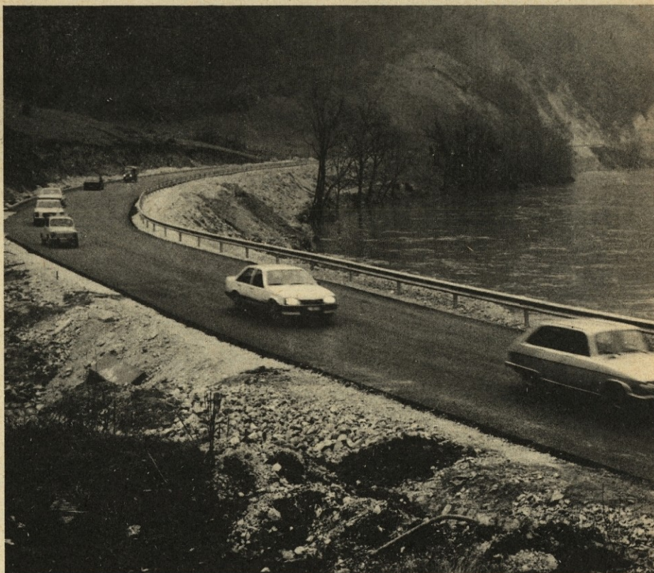
Ob otvoritvi modernizirane ceste ob Savi od Zagorja proti Trbovljam so se odpeljali udeleženci otvoritve po novi cesti proti Trbovljam. (foto: B. Klančar)
