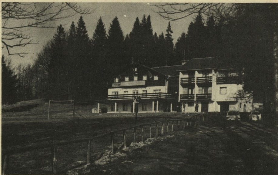
Rudarski planinski dom na Kalu. Levo stari, obnovljeni del, desno novi del doma. (foto: B. Klančar)
