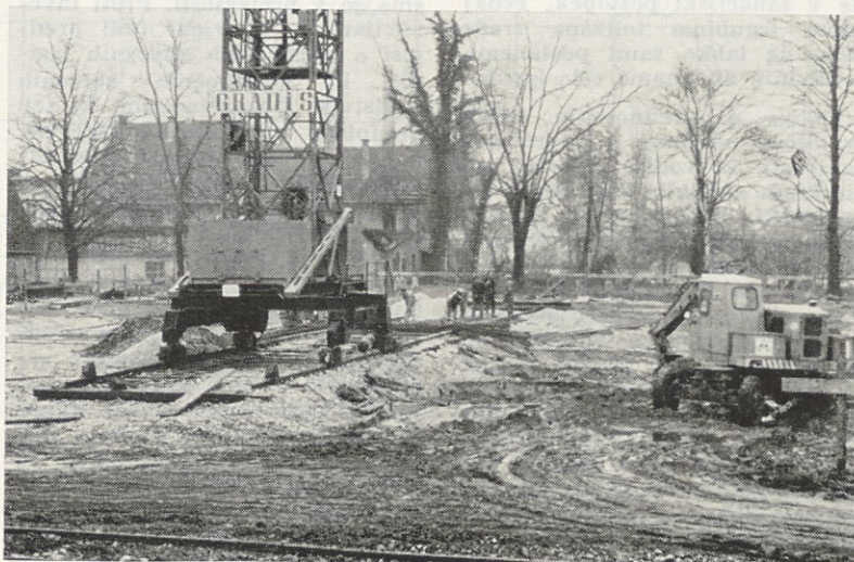
Začela se je gradnja stavbe obrata za izdelavo zidnih tapet (stanje 4. 12. 1972)
