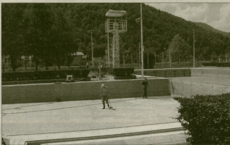
ZPO je z izvajalcem in upravnikom bazena, podjetjem Trio, pričel s pripravami bazenov že aprila, ko so najprej temeljito oprali in popravili bazensko školjko.
