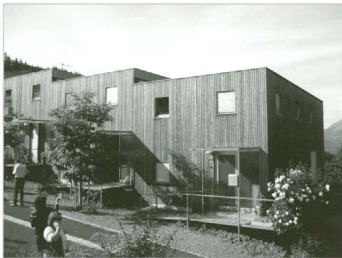
Slika A: primer pasivnih lesenih hiš; severna fasada iz lesenih macesnovih desk (starost 10 let) v Švici
