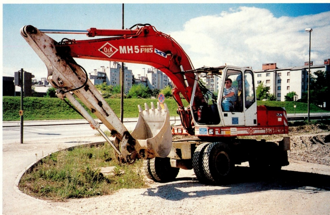
Slika 3: Testni gradbeni delovni stroj
