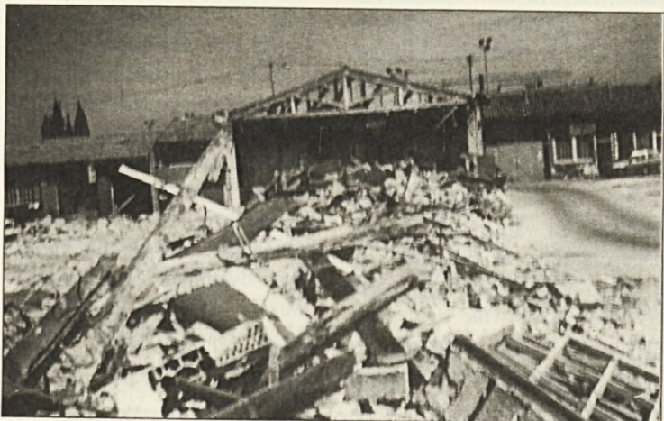
Podiranje Stavbenikovih delavnic v Tomažičevi
