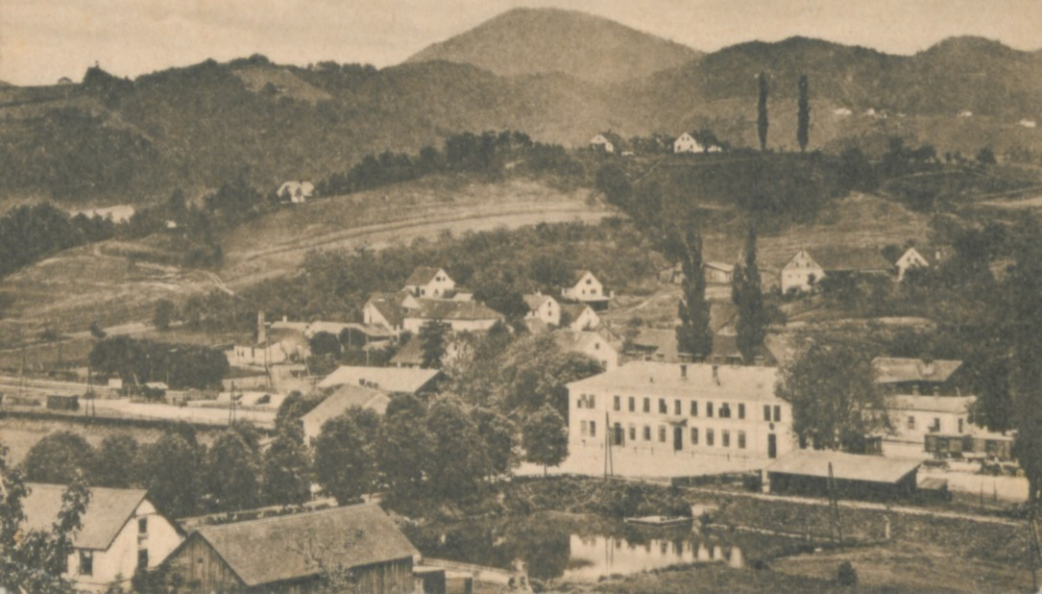
Hölldorf mit Bahnhof Pölttschach
