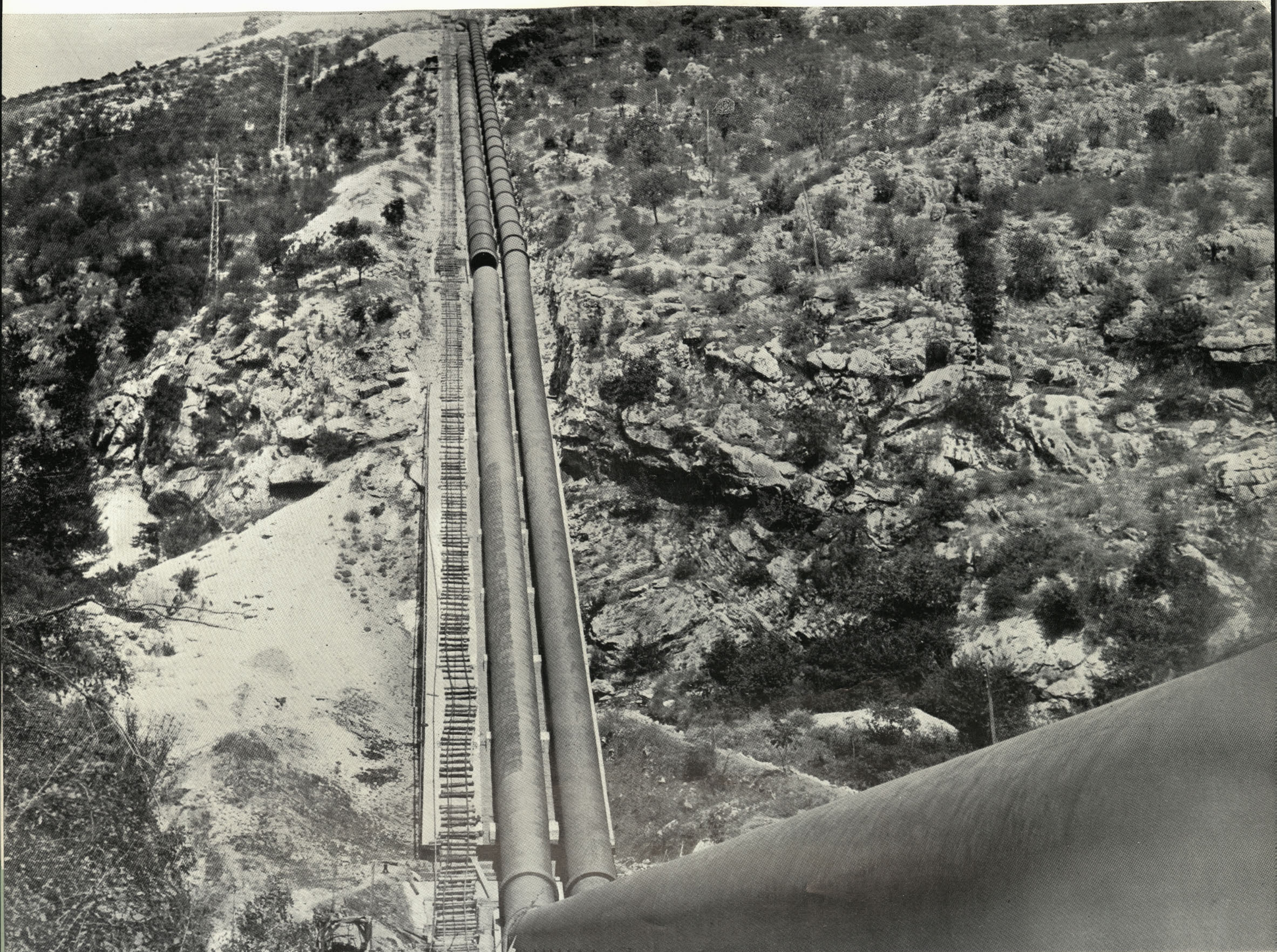
Montaža 2040 m dolgega cevovoda s premerom cevi 2200 mm in 2100 mm
