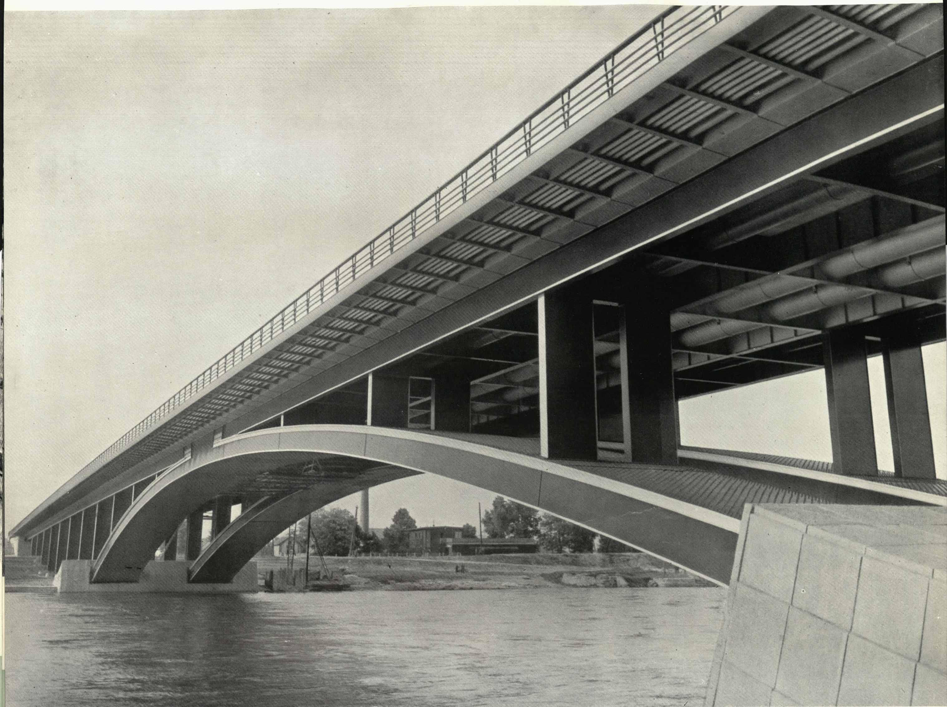
Cestni most varjene in kovičene izvedbe, dolg 372 m in širok 20 m.
