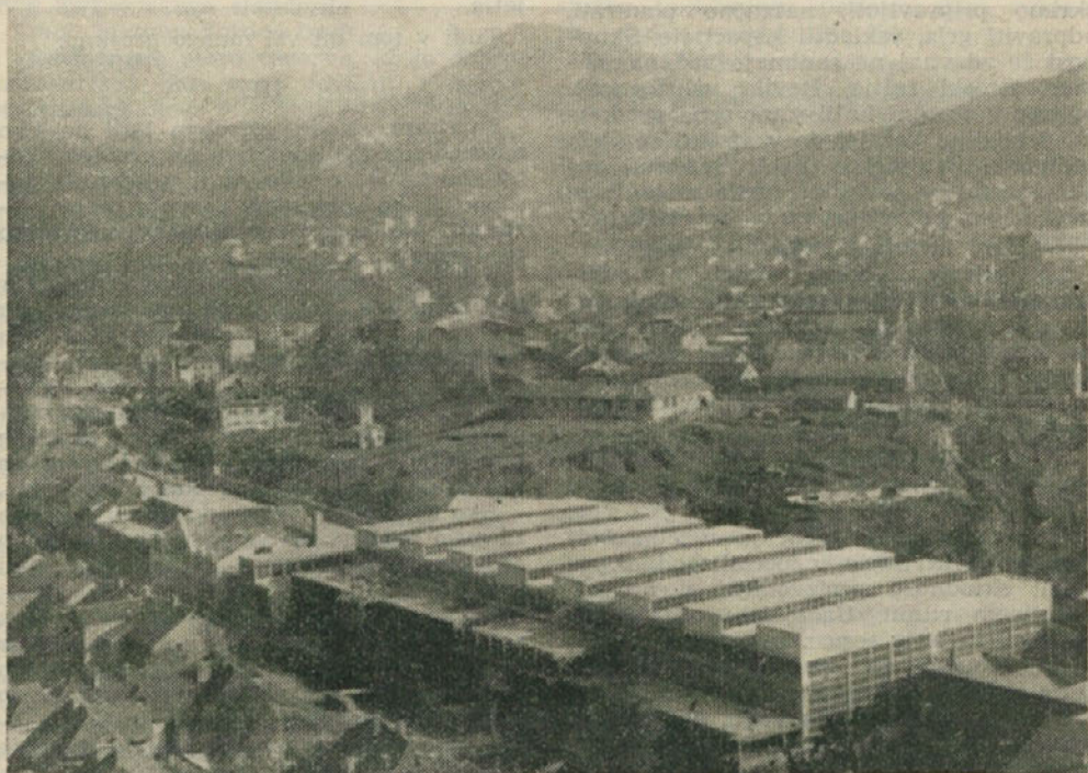
Tudi Strojno tovarno v Trbovljah je zgradil kolektiv Betona
