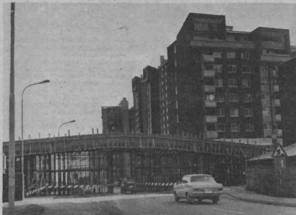
NADHOD ZA PEŠCE - V Soseski 7 gradljo nadhod nad Ulico 7. septembra, ki bo povezoval Glinškovo ploščad in zahodni del Bratovševske ploščadi. Objekt je seveda že dobil ime: pravijo, da je to »most vzdihlajev«.
