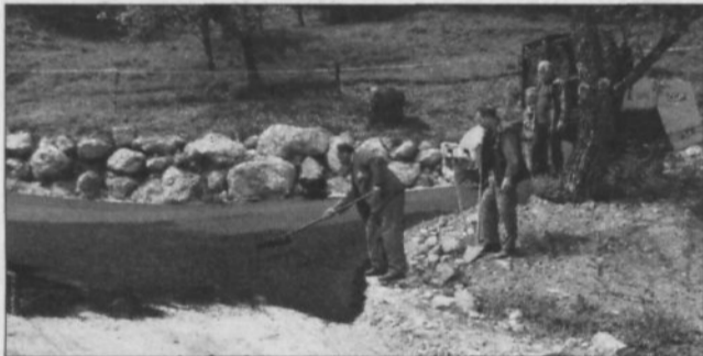
Asfaltacija odseka (vir: KS Sevnica)
