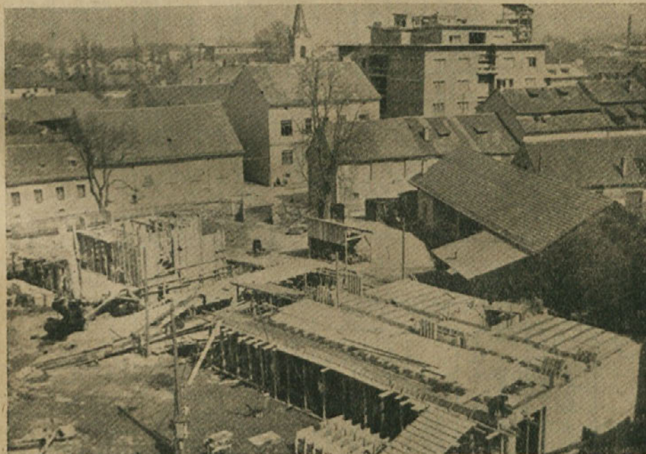
Gradnja stanovanjskega bloka v Ključavničarski ulici v Celju
