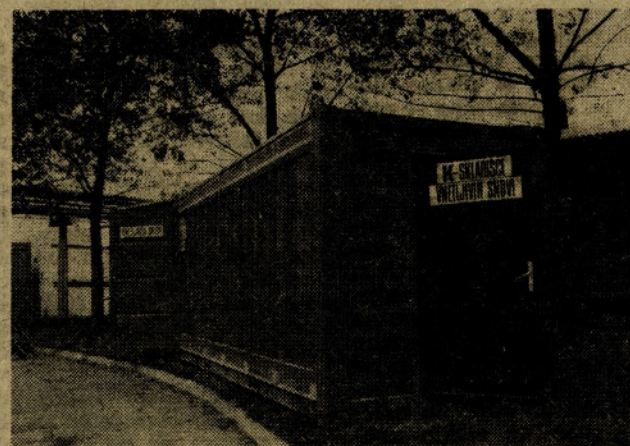
Novo oziroma spremenjeno skladišče vnetljivih snovi. Enostavnejša konstrukcija, ustrežnejše prilagojen obstoječemu procesu proizvodnje, uporabljen skoraj v celoti domači material, manjša teža, skratka mnogo večja funkcionalnost ter precej krajši čas izdelave
