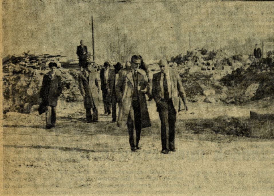
Predstavniki firme Klöckner Wärmetechnik iz Duisburga so si ogledali tudi gradnjo naše nove tovarne energetske opreme v Šentjurju
