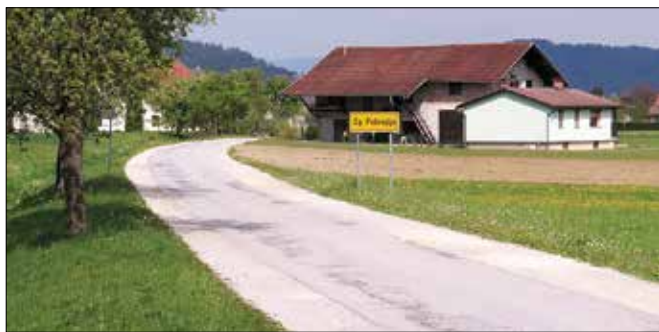
Prepotrebna obnova ceste Trnovec-Pobrežje je predvidena v celotni dolžini v letih 2019 in 2020 ob predpostavki, da ne pride do nepredvidenih zapletov. (Foto: IS)
