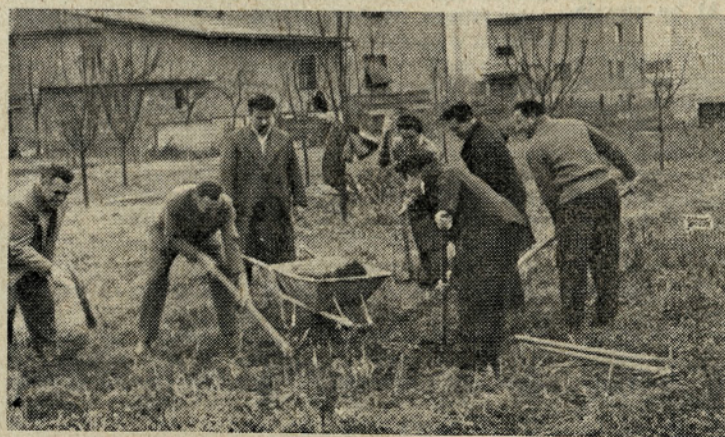
Člani kolektiva so zasadili prve krampe in lopate na gradbišču samskega doma
