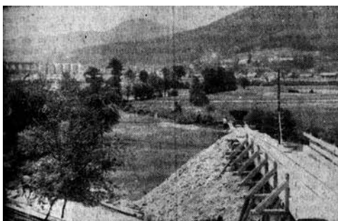
24. Preko ravnine grade v širokem loku nov železniški nasip. V ozadju opuščeni borovniški viadukt. Pod njegovimi širokimi oboki na levi bo zgrajena nova borovniška postaja. Slovenski poročevalec, 9. junij 1946.
