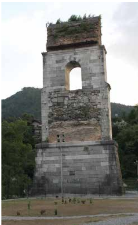
35. Zadnji steber Borovniškega viadukta, leta 1992 proglašen za tehniški spomenik. (foto: Tatjana Oblak Milčinski, 2018).
