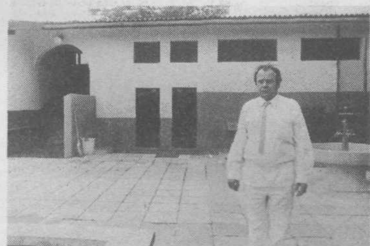
Martin Lisjak pred prenovljenim poslopjem ob bazenu, v katerem so garderobe in še drugi prostori (Foto: D. J.)
