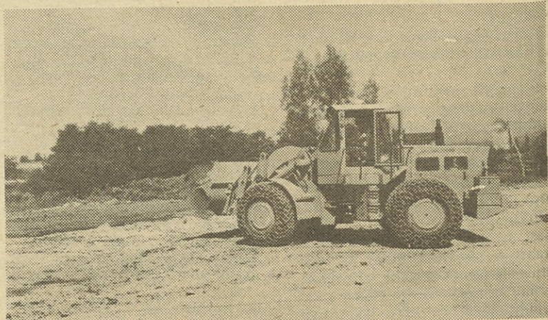
TOZD ELEKTROLITSKI KONDENZATORJI MOKRONOG: Prejšnji teden so začeli z zemljskimi deli za gradnjo nove tovarne. Vodja gradbišča, gradi Gradbeno podjetje Grosuplje, mi je zatrdil, da se bodo potrudili in da bo stavba do zime pod streho. Tako bodo čez zimo lahko opravili notranja dela in instalacije.
