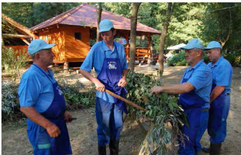
Prikaz izdelave fašine na Būjraških dnevih
