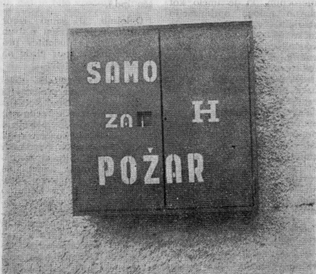
V osmih ličnih in na novo opremljenih omaricah hranimo potrebno gasilsko opremo za gašenje požarov s pomočjo hidrantov — zato so nameščene v bližini le-teh.
