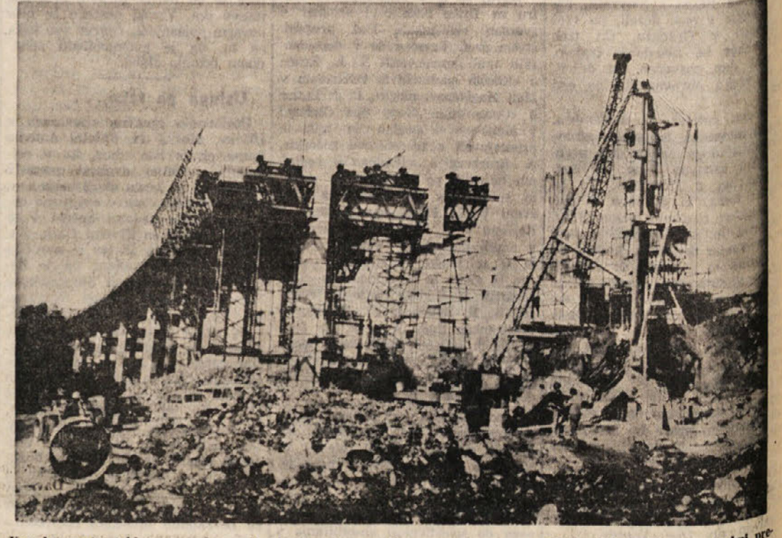
Ker bo cesta tekla po «zelo razčlenjenem» terenu, to se pravi po precej hribovitih krajih, so potrebni pre- cejni viadukti in več mostov. Na sliki vidimo gradnjo enega izmed viaduktov, katerega obrisi se šele kaže- jo iz ogromnega ogrođa.
