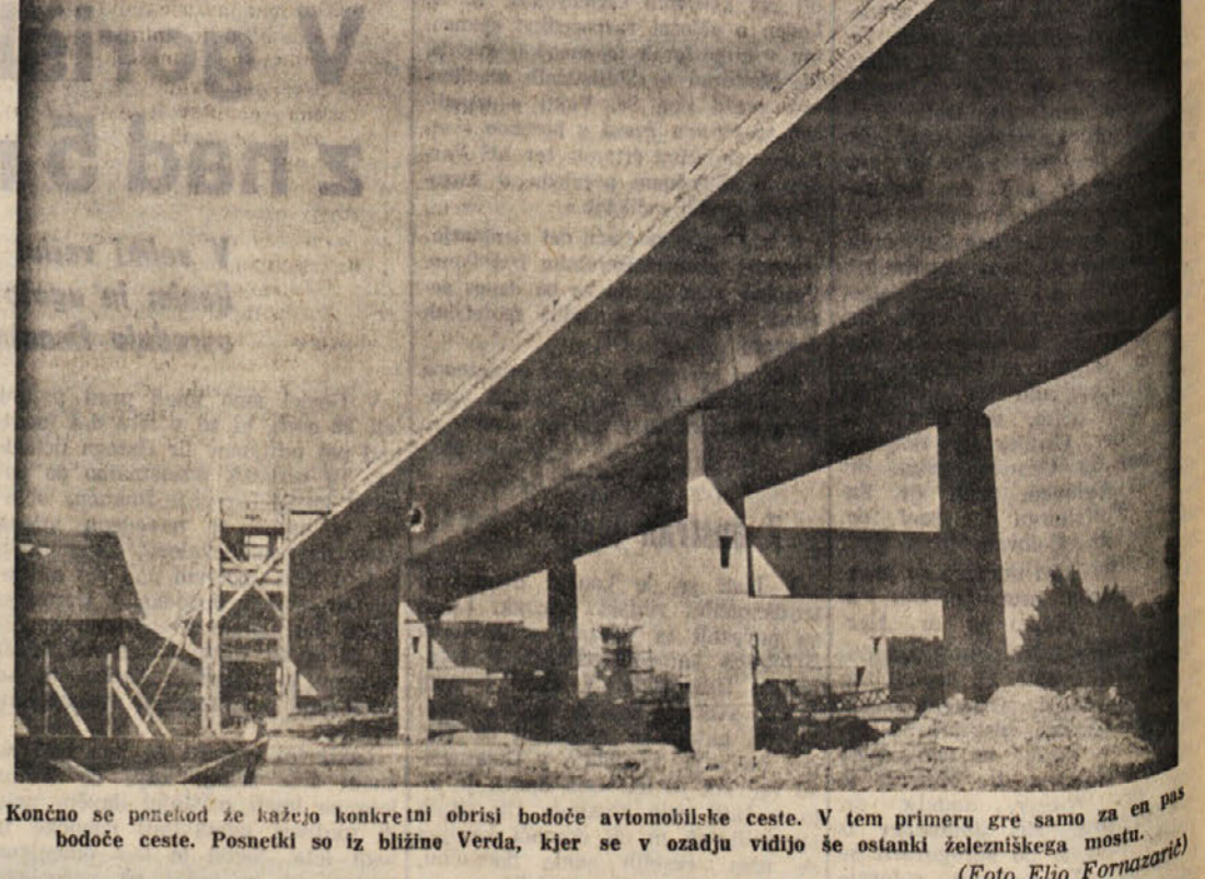
Končno se pomečlo že kažejo konkretni obrisi bodoče avtomobilske ceste. V tem primeru gre samo za en pas- bodoče ceste. Posnetki so iz bližine Verda, kjer se v ozadju vidijo še ostanki železniškega mostu. (Foto Elio Fornazari)
