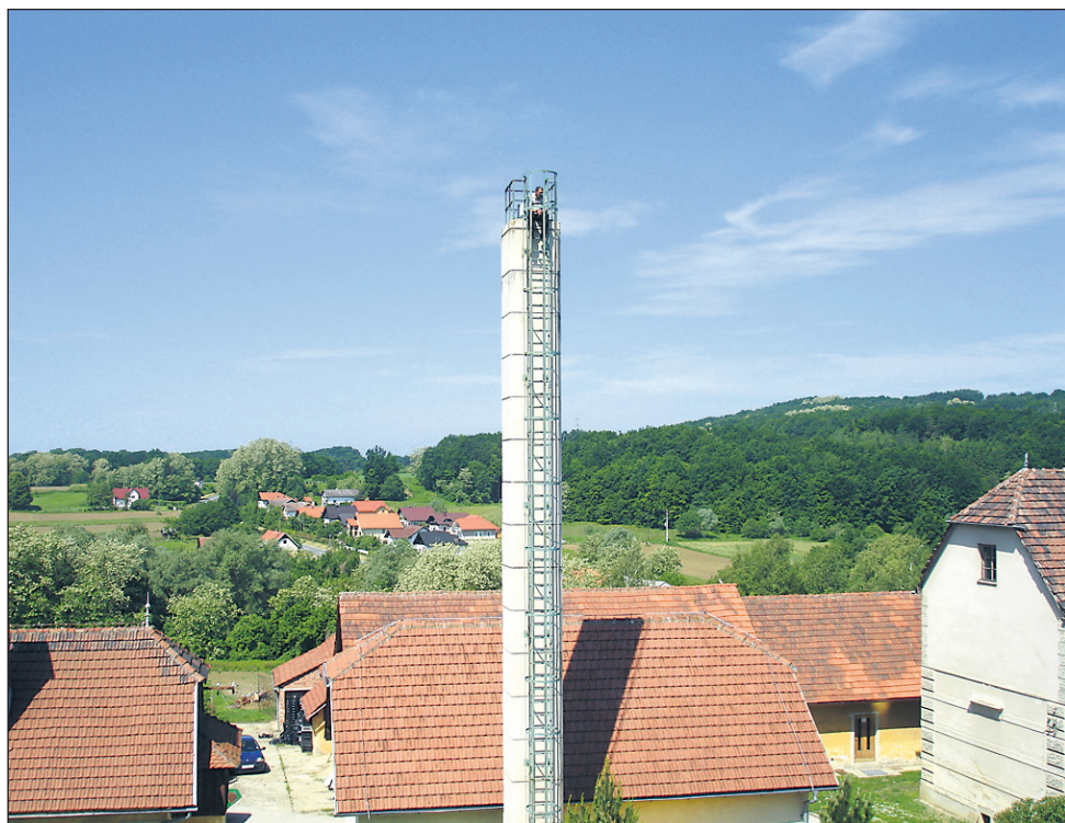
Dimnik je visok okrog 18 metrov, zato je bila nevarnost, da se zgodba konča tragično, velika. Foto: vki
