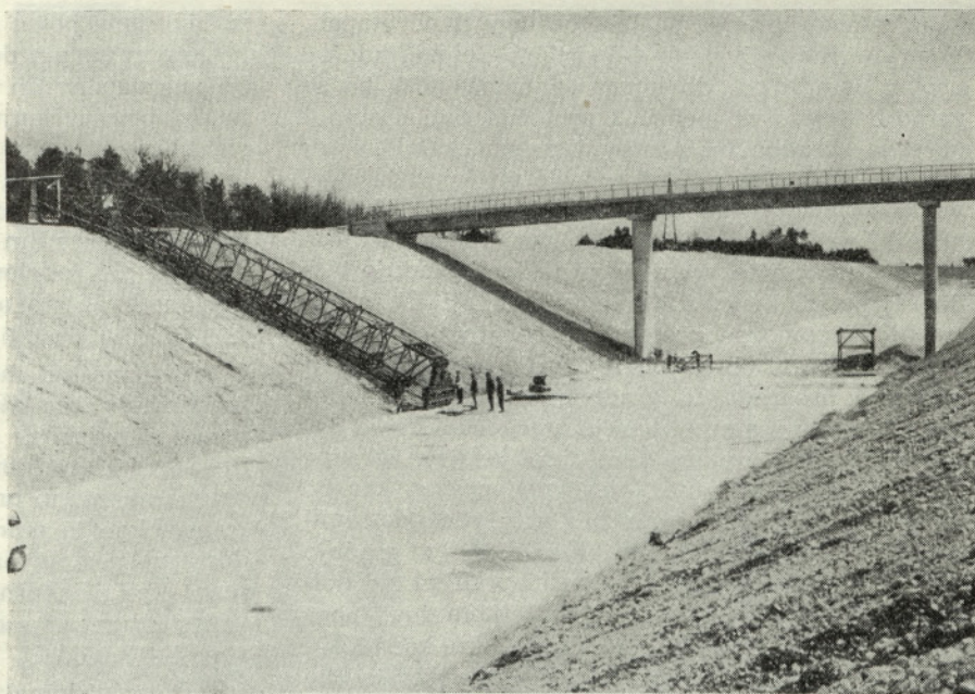
Planiranje brežin dovodnega kanala
