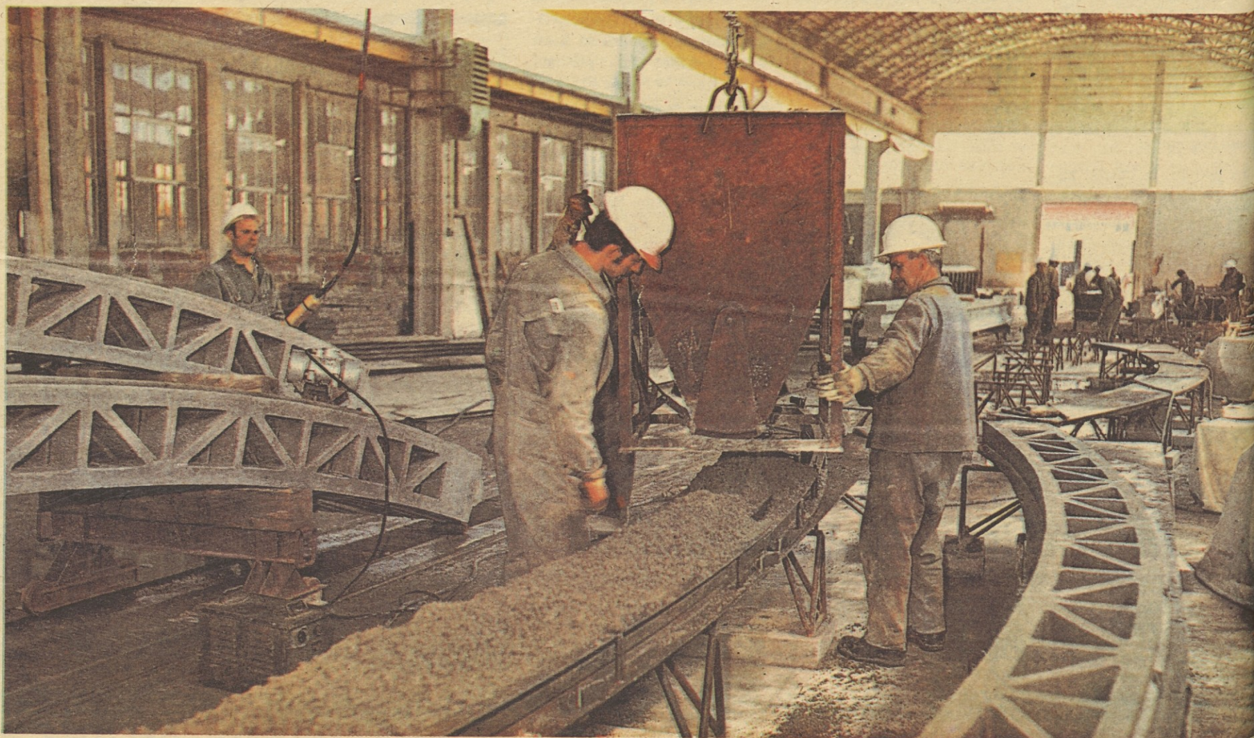
Betoniranje armiranih betonskih korit v SGP Gorica za kritje montažnih hal
