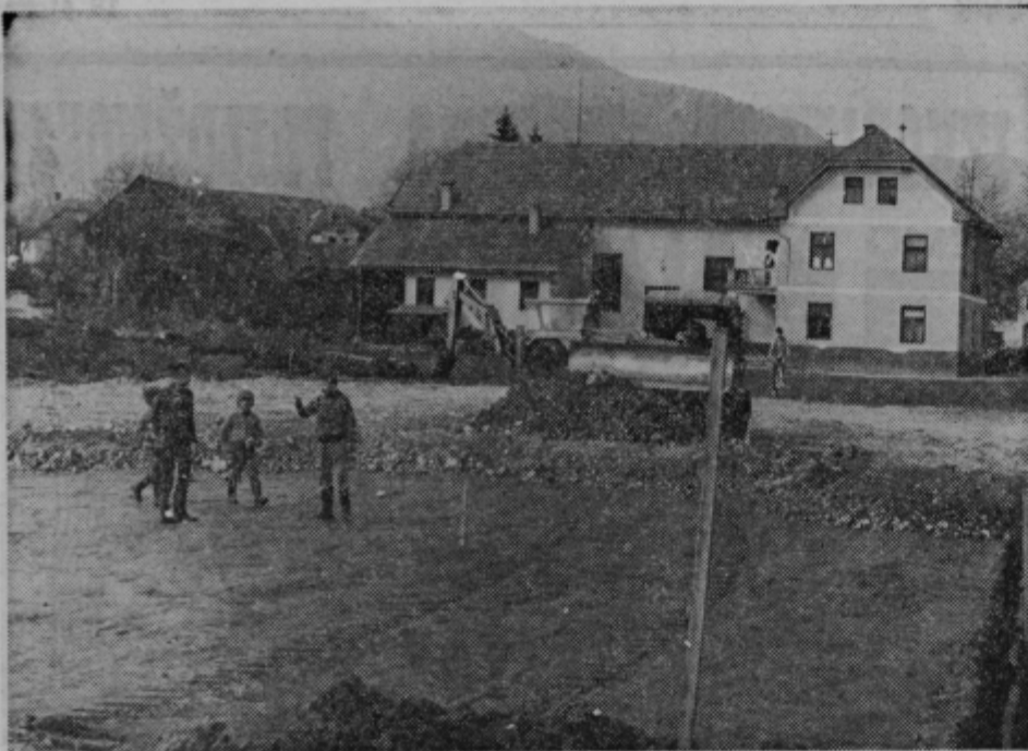
V Braslovčah se pred dnevi pričeli graditi novo rokometno igrišče. Z deli bodo verjetno končali do 29. novembra, ko bodo imeli slovesno otvoritev in turnir. Če bodo zbrali zadostno število sredstev, bodo igrišče tudi asfaltirali. Foto: T. Tavčar
