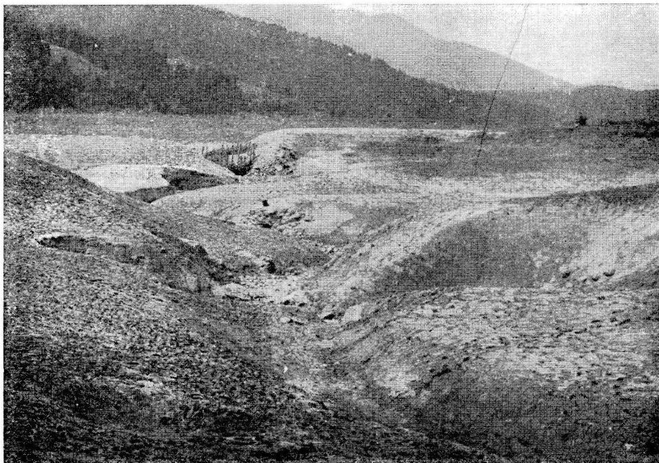
Sl. 4. Stari ribiški jez pred skupino požiralnikov v Rešetju je voda predrila
