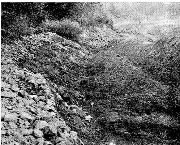
Sl. 14. Regulirana struga Stržena v Jamskem zalivu je polna manjših požiralnikov
