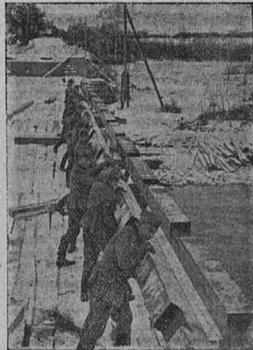
Vzorna gradnja mostu, ki jo izvršuje državna delovna služba na vzhodu. Podolžne mostnice privažajo in gradijo.
