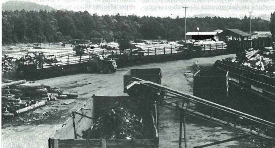
Za prevoz drogov za vode so najbolj primerni vagoni serija R, za nakladanje oblega lesa pa VOVLO nakladalniki
