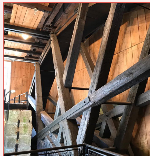
Kamšt je največje leseno kolo v Evropi, postavljeno v sedanji izvedbi okoli leta 1790 kot črpalna naprava za odvečno vodo v rudniku živega srebra.
